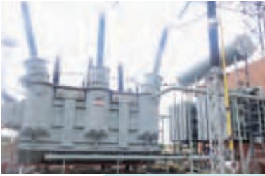
315 MVA, 400/220/33 kV MSETCL
